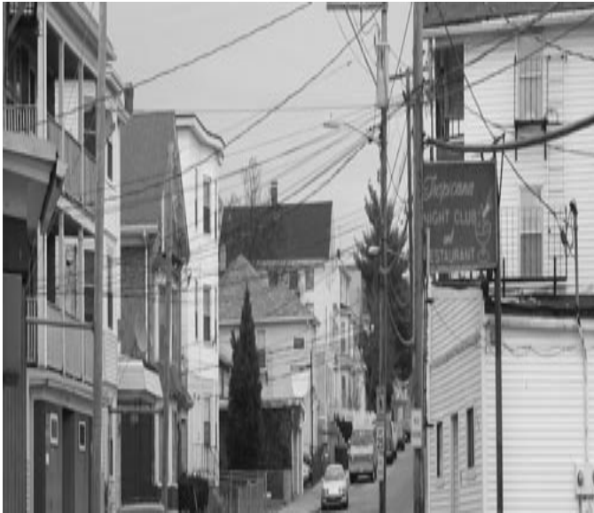
Algunos de los cables Hitchconianos en Central Falls
