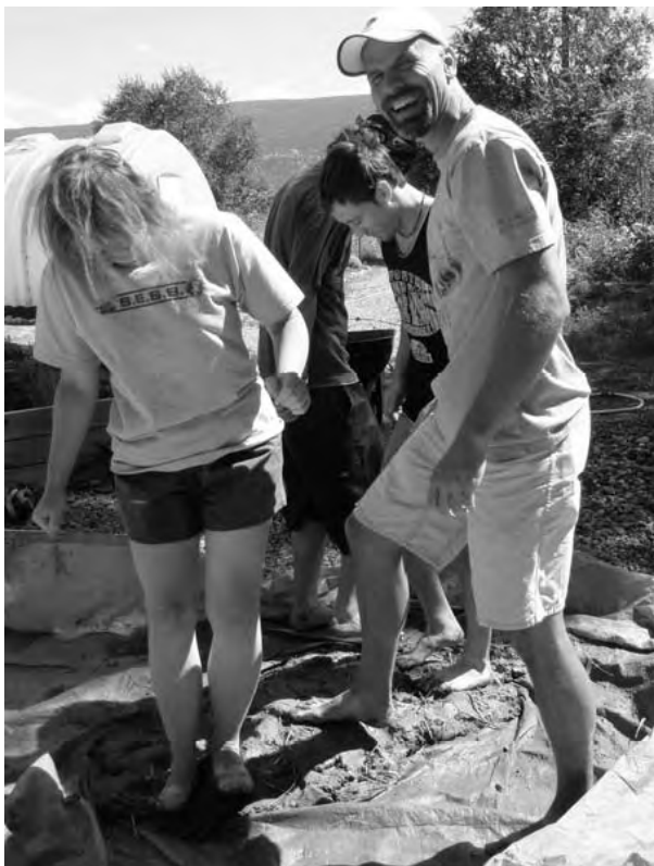
Los estudiantes prueban sus habilidades en el arte antiguo de la construcción con cob a partir de la mezcla cooperativa de barro, arena y pajas.
