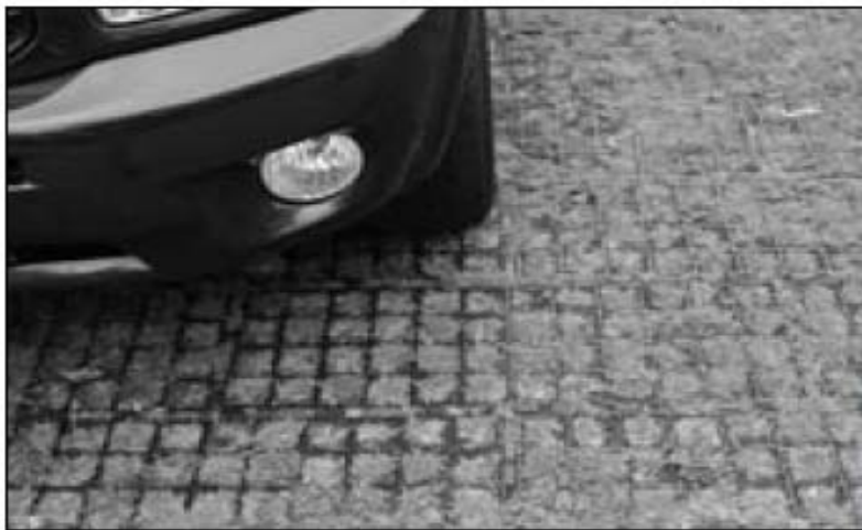
Foto: Pavimento permeable hecho de plástico reciclado que permite que el agua de lluvia se filtre a la tierra de manera natural en lugar de al sistema municipal de drenaje.
